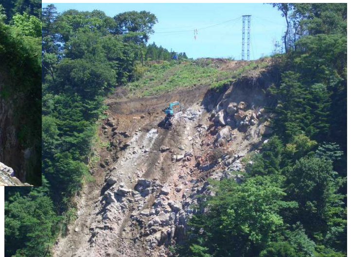
△無人重機(RCM)の遠隔操作による作業▷
