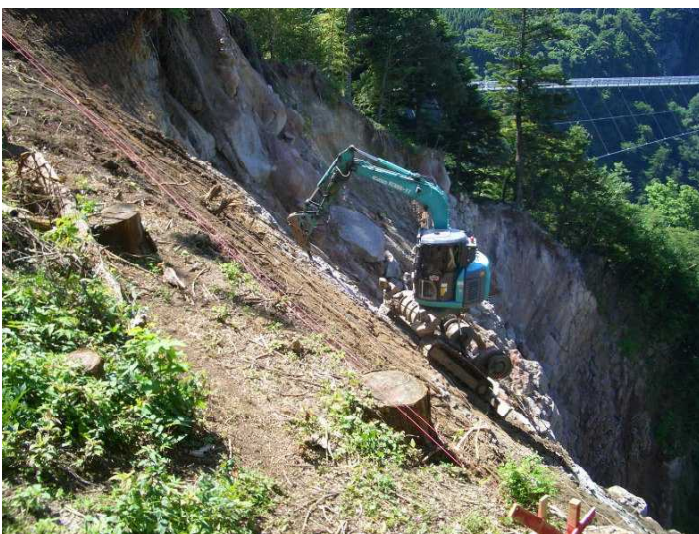
△無人重機(RCM)の遠隔操作による作業▷
