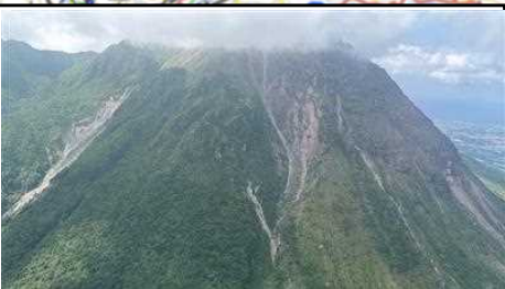
②長崎県島原市「普賢岳」（国有林） 溶岩ドームの一部崩落を確認した
