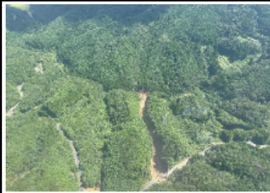
③熊本県上天草市(民有林) 山腹崩壊を確認
