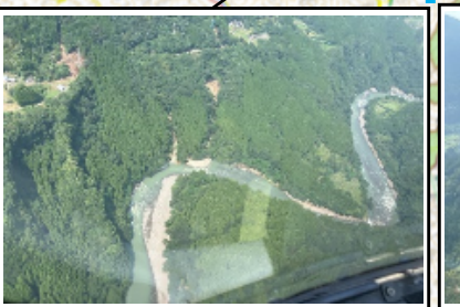
⑨熊本県美里町(民有林) 山腹崩壊を確認
