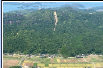
⑥熊本県上天草市(民有林) 山腹崩壊を確認
