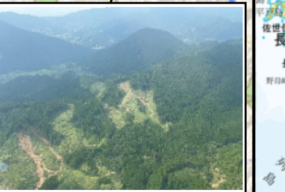
⑩熊本県美里町(民有林) 山腹崩壊を確認
