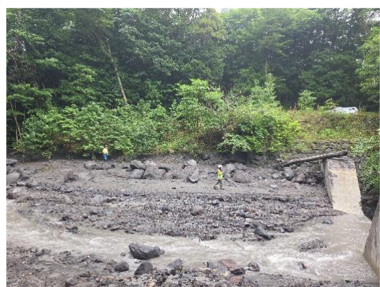
① 既設治山ダム背面の状況 治山ダムの背面が満杯となっている状況を確認
