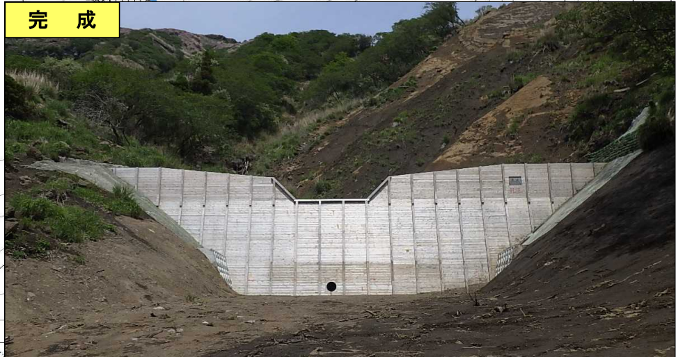
No. 1コンクリート谷止工
