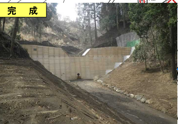
No. 1コンクリート谷止工
