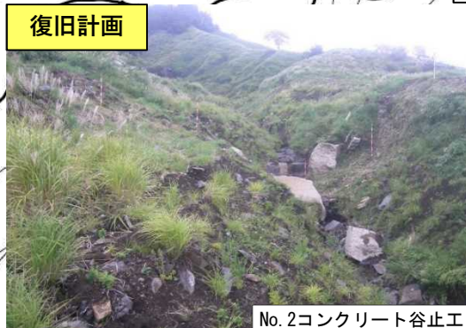
No. 2コンクリート谷止工
