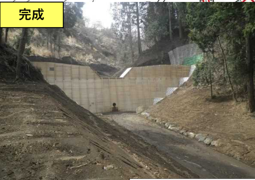
No.1コンクリート谷止工
