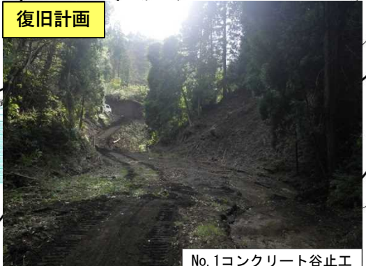
No.1コンクリート谷止工
