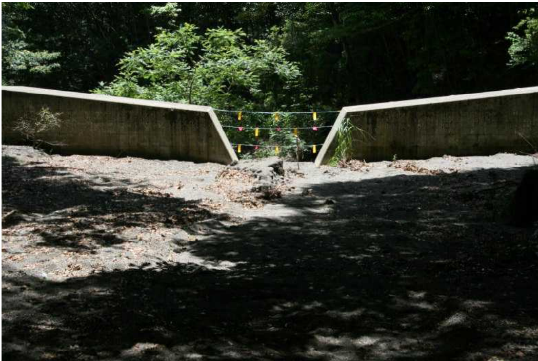
治山ダム上流の状況
