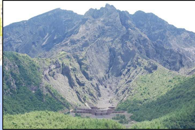
引の平沢地区荒廃及び復旧状況
