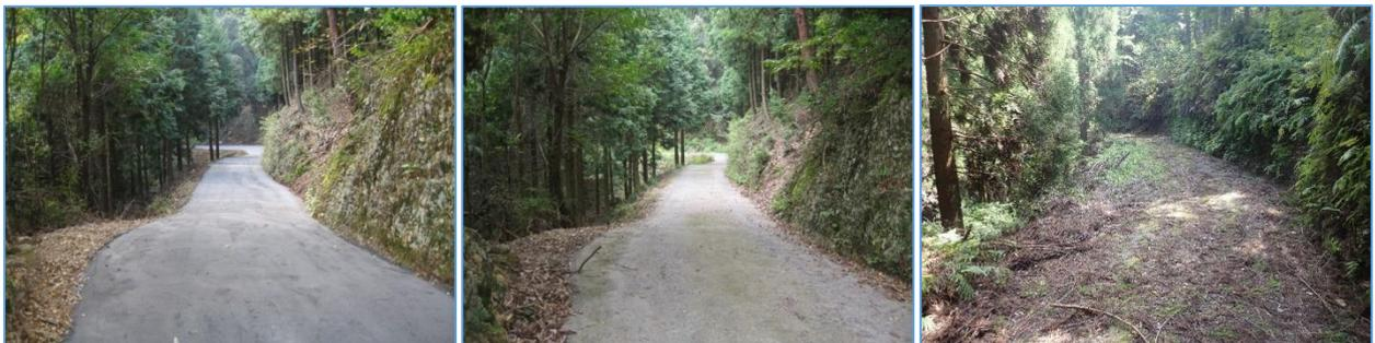
(写真4) 佐伯市の施工地の状況 (左: 施工時、中央: 施工2年後、右: 施工11年後)
