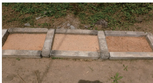
竹チップと固まる土舗装試験
