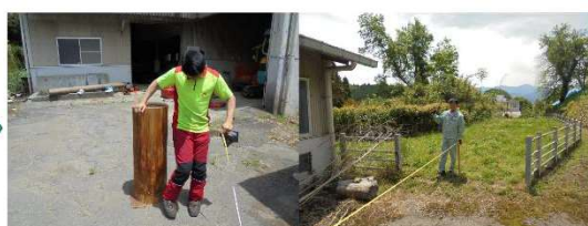
②固定した丸太の中心から15m離れた地点に目標を設置する
