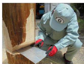
⑤水系を使って受口の伐倒目標とのずれを確認
