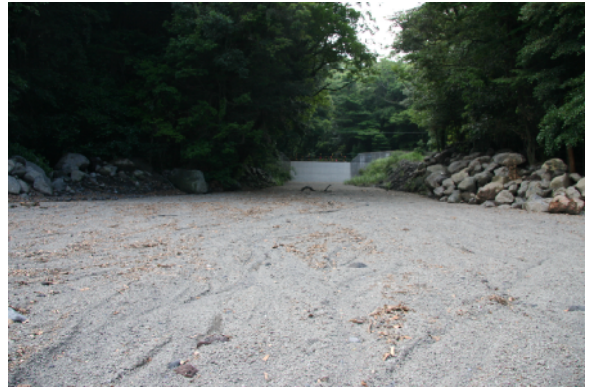
排土した空間に流下土砂を捕捉した状況
