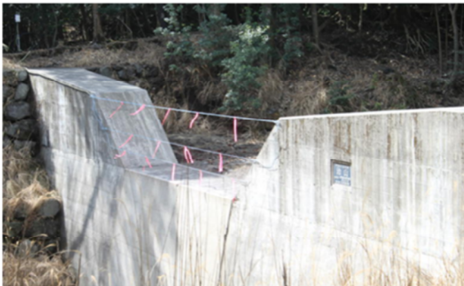
土石流センサーの設置
