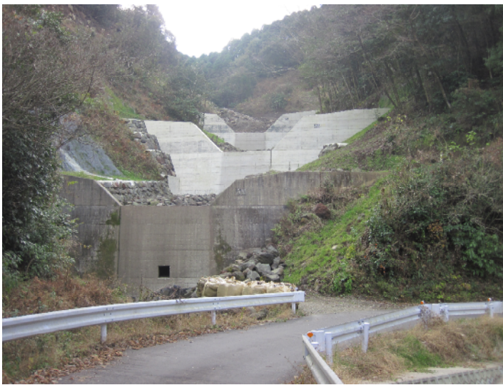
都城市の丸谷川流域に完成した治山ダム
