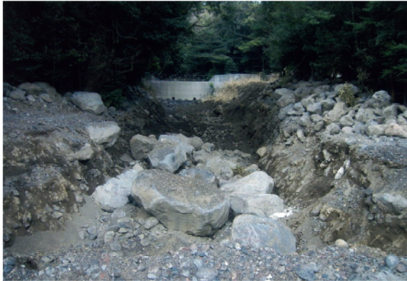
排土した状況
