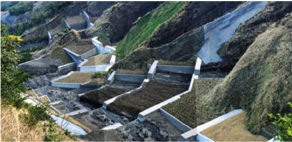
治山ダムによる溪床勾配の緩和、山脚の固定、土砂流出の抑止
