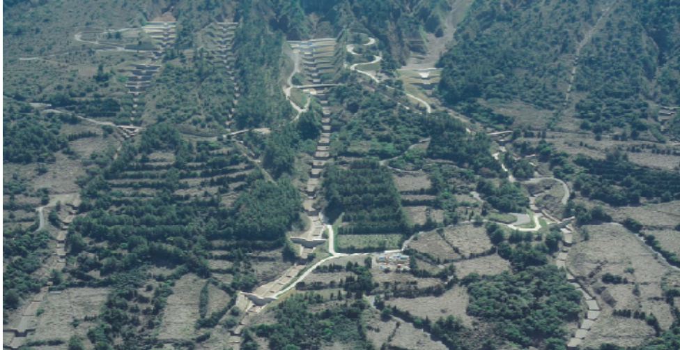
治山ダムによる溪床勾配の緩和、山脚の固定、土砂流出の抑止
