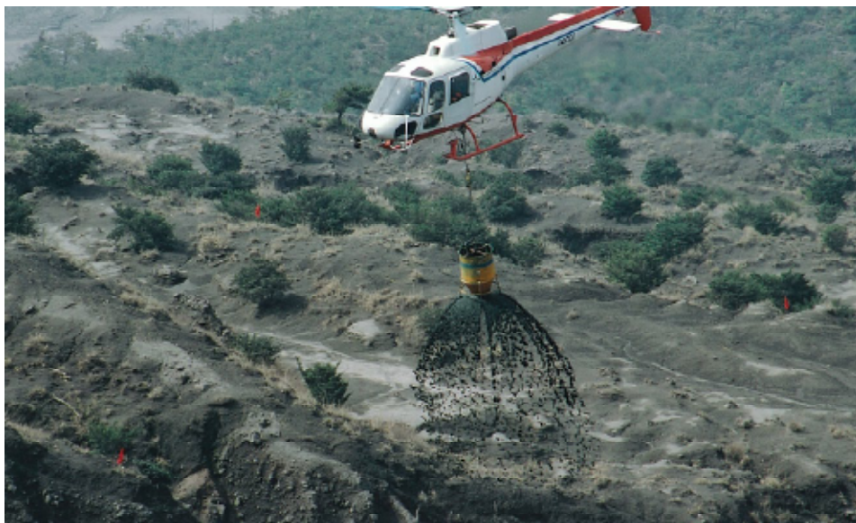
山腹荒廃地への航空実播工による緑化
