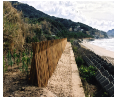
丸太防風柵工 (福岡森林管理署管内)
