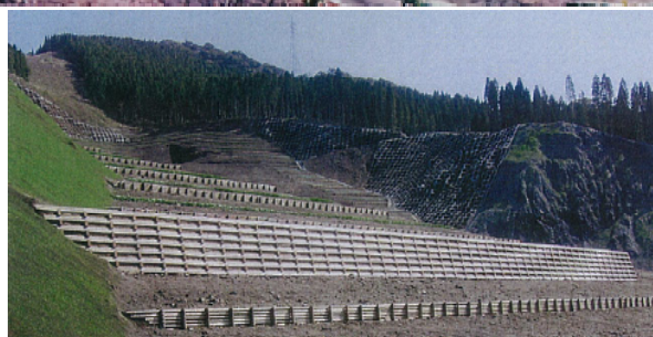
木製井桁土留工と木柵工
