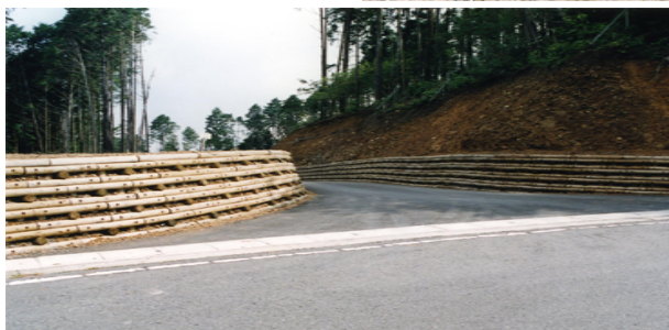
木製土留工(ウッドブロック) (大分森林管理署管内)
