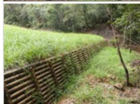
平成23年度に木材を利用した治山工事を施工し、現在では植生が回復し緑化が進んでいる状況がうかがえます。(施工直後から約6ヶ月後の緑化の進行状況)
