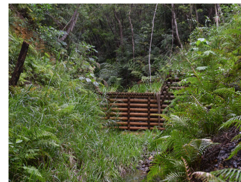
施工完了より4年後
