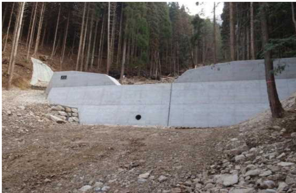
治山工事完了後 (平成26年1月完成)
