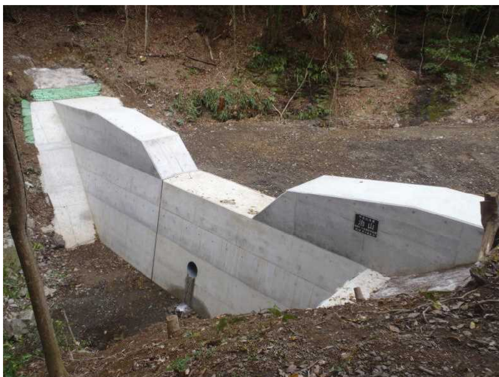
治山工事完成後 (平成25年12月完成)
