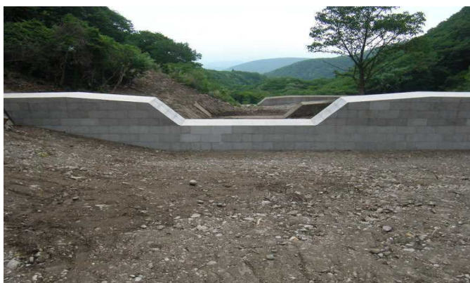
治山工事完了後の状況（上流）（平成26年6月完成）
