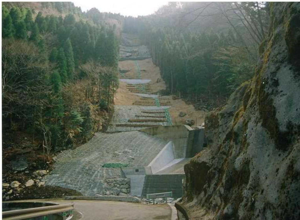
治山工事完了後の状況 （工事区域の大部分） （平成21年3月）
