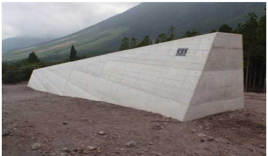
新設した導流堤の状況 （平成25年9月完成）
