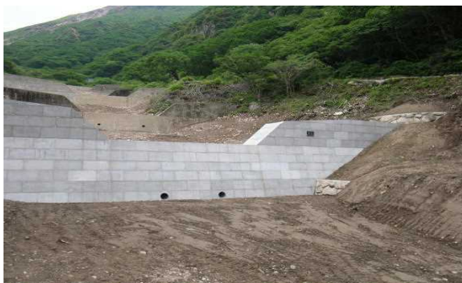
治山工事完了後の状況（下流）（平成26年6月完成）
