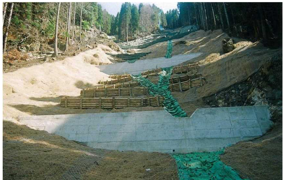
治山工事完了後の状況 （土留工と、間伐材 を利用した柵工の様子） （平成21年3月）
