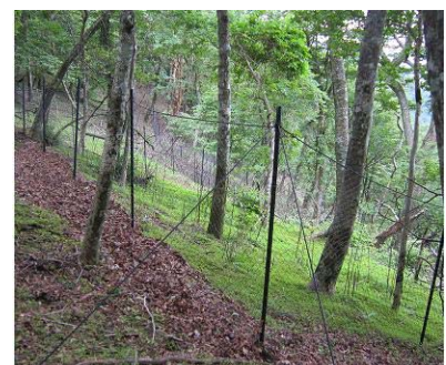
傾山稜線での獣害防止ネット設置
