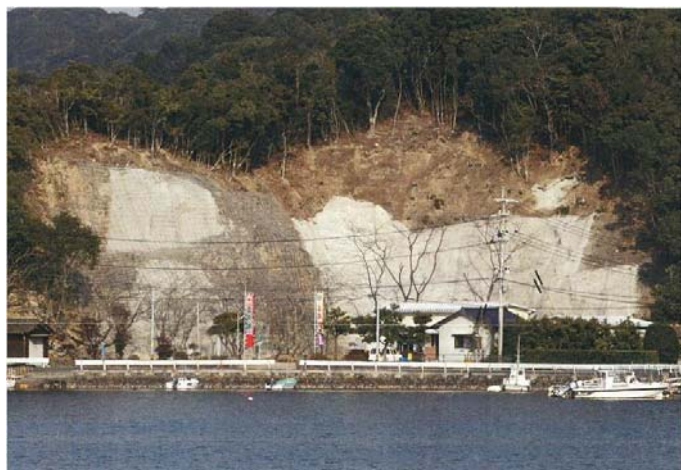
山腹工施工後（大江灘国有林）
