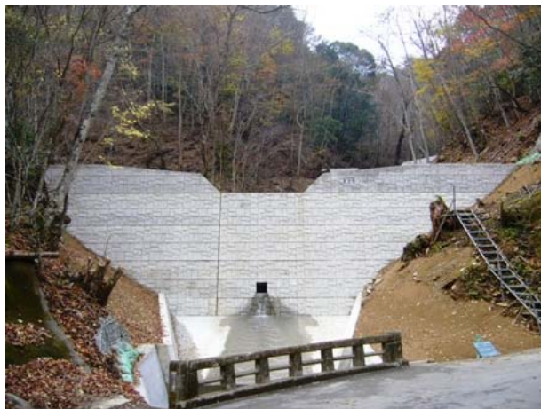
治山ダム施工後（傾山国有林）
