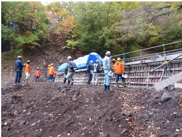
安全パトロールの様子
