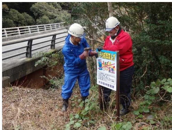
看板設置の様子
