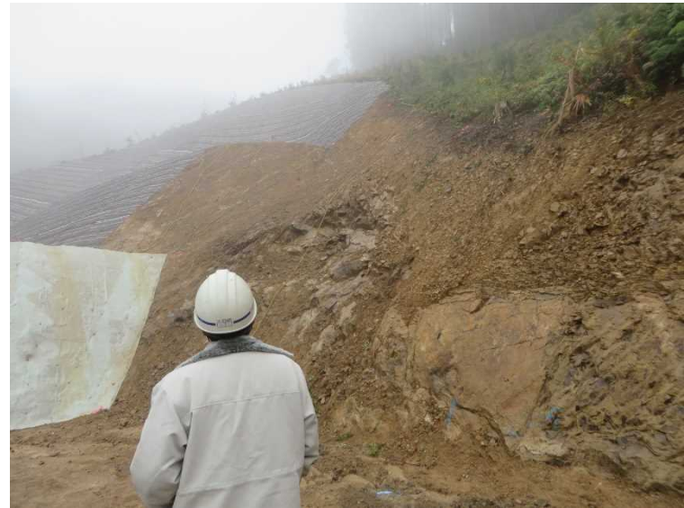
法面作業箇所の点検
