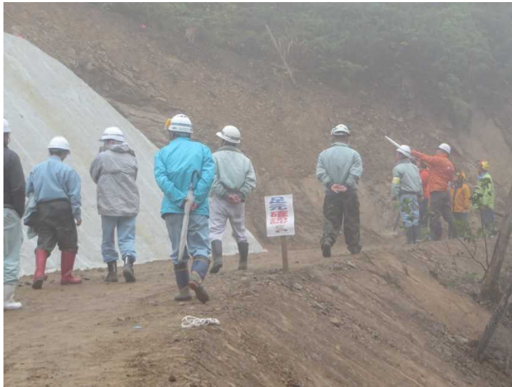
法面作業箇所の点検
