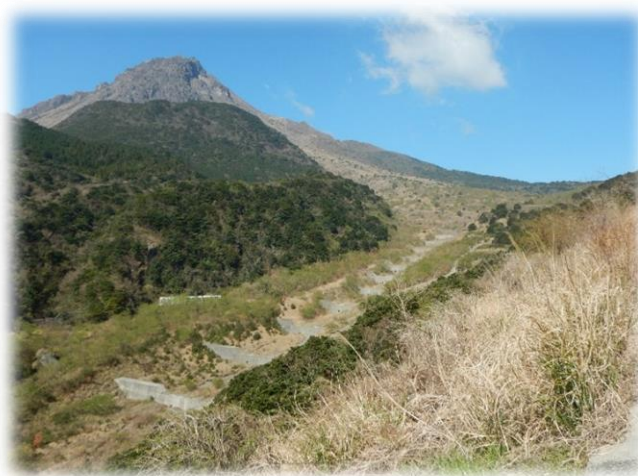
長崎南部流域 平成新山と治山堰堤
