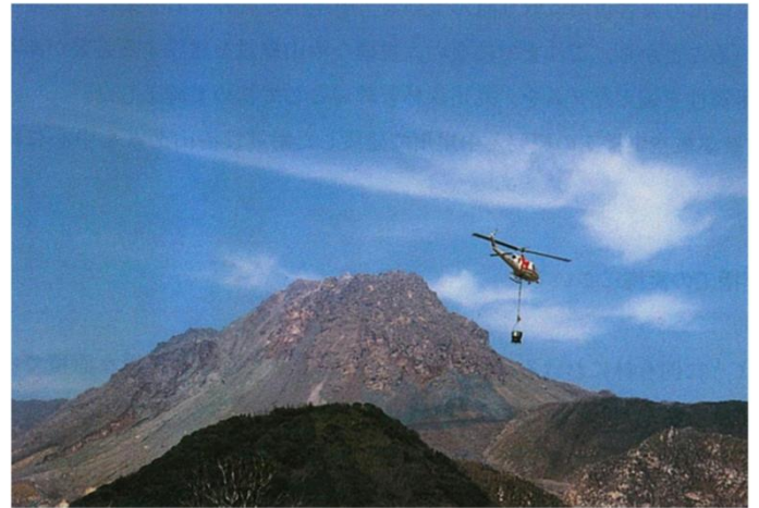
・ 航空実播工の施工状況
