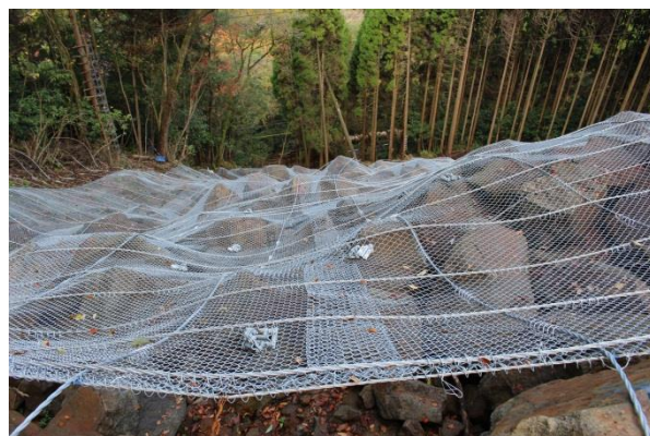
(写真3) 山腹工の状況（落石防護ネット工）
