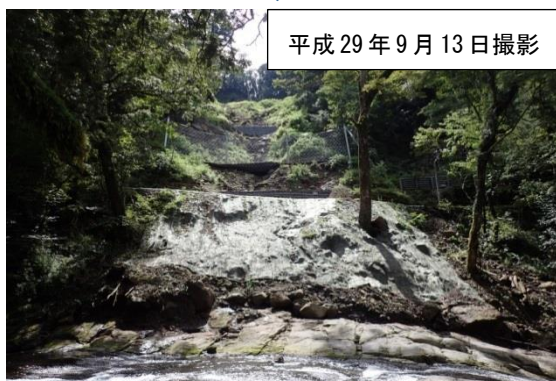
(写真 4, 5) 菊池渓谷内の復旧状況
