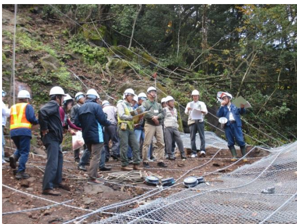
(写真1) 治山事業現場を見ながら説明
