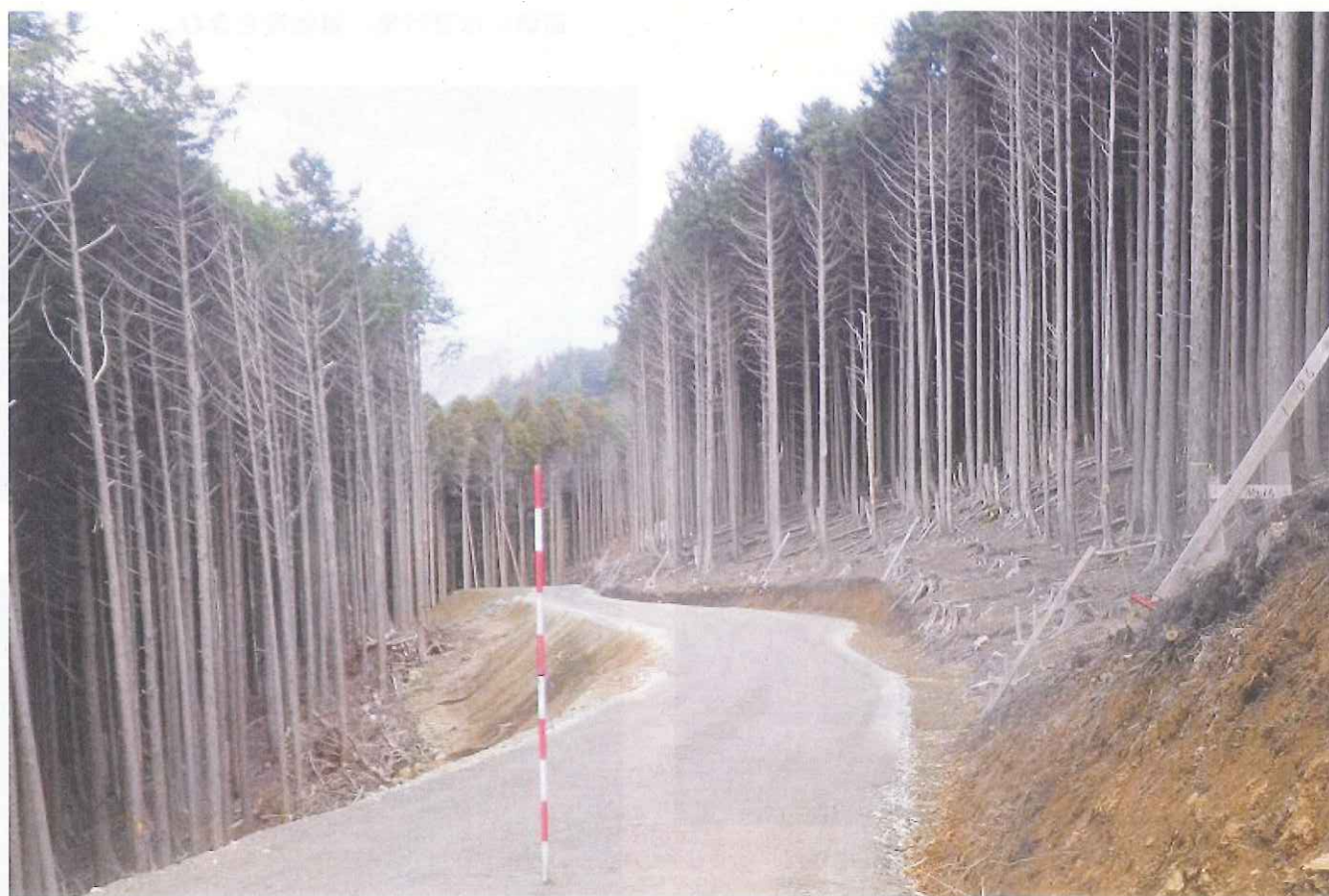
間伐実行のための林業専用道開設状況（2167林班内）
