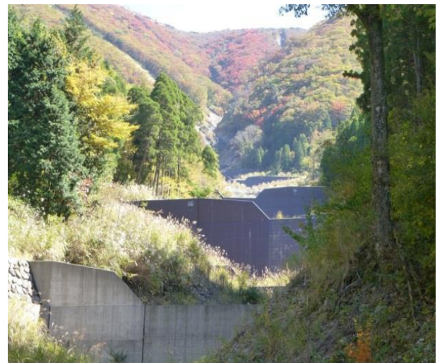
北里川上流の土砂流出防止谷止工群 （源太園国有林240林班）
