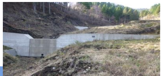
治山工事（谷止工群） 根子岳南面（猫岳国有林 2 2 3 林班）
