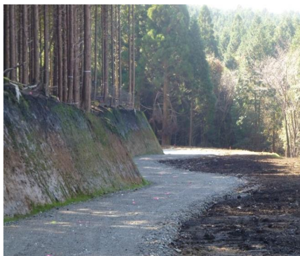
グリーンロード沿い 吉無田林道 新設箇所 （大野国有林野1130林班）
