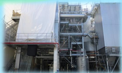
バイオマス発電所
