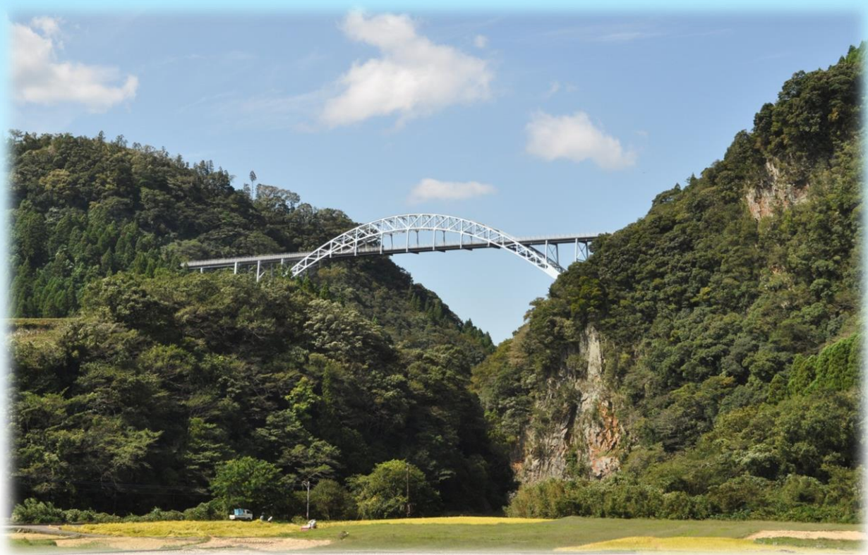
内大臣橋（山都町） （長さ 199m ・ 高さ 88m）
