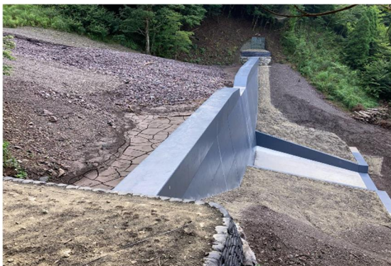
流出した不安定土砂の捕捉状況 （小国町 源太園国有林）
