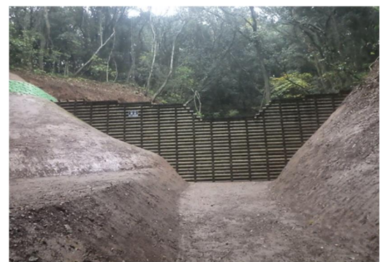
木製谷止工による施工状況 （宇土市 西木原国有林）
