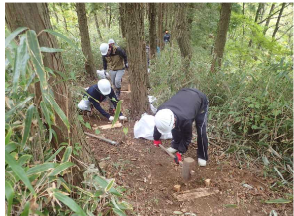
(歩道補修作業の様子)
