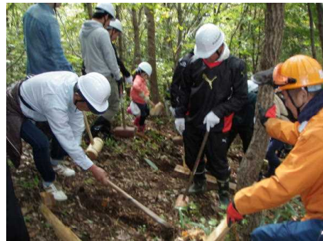
(歩道補修作業の様子)
