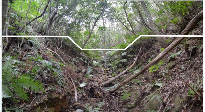
平良（1）2 治山工事
