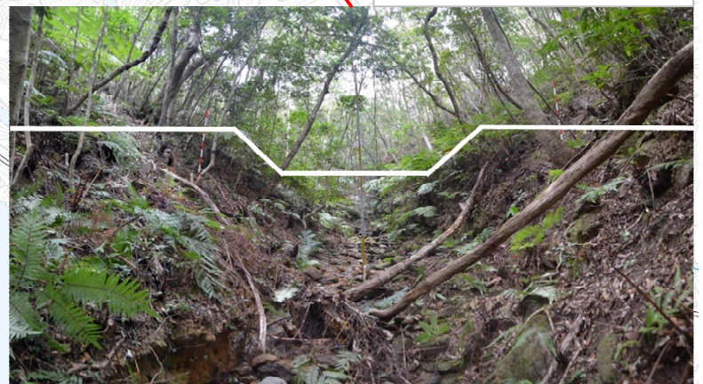
平良（1）2 治山工事
