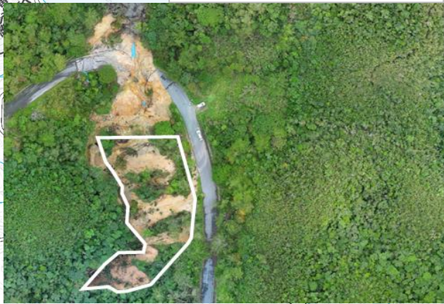
平良治山工事（関連災）
