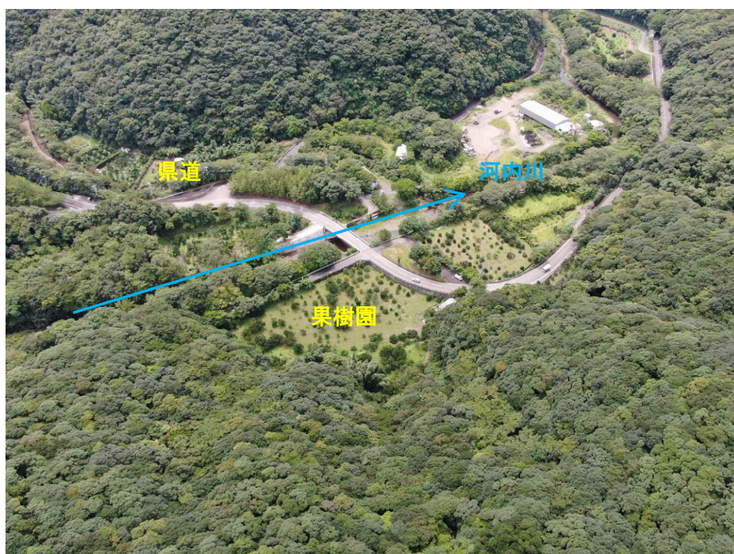
全景(下流の状況)
