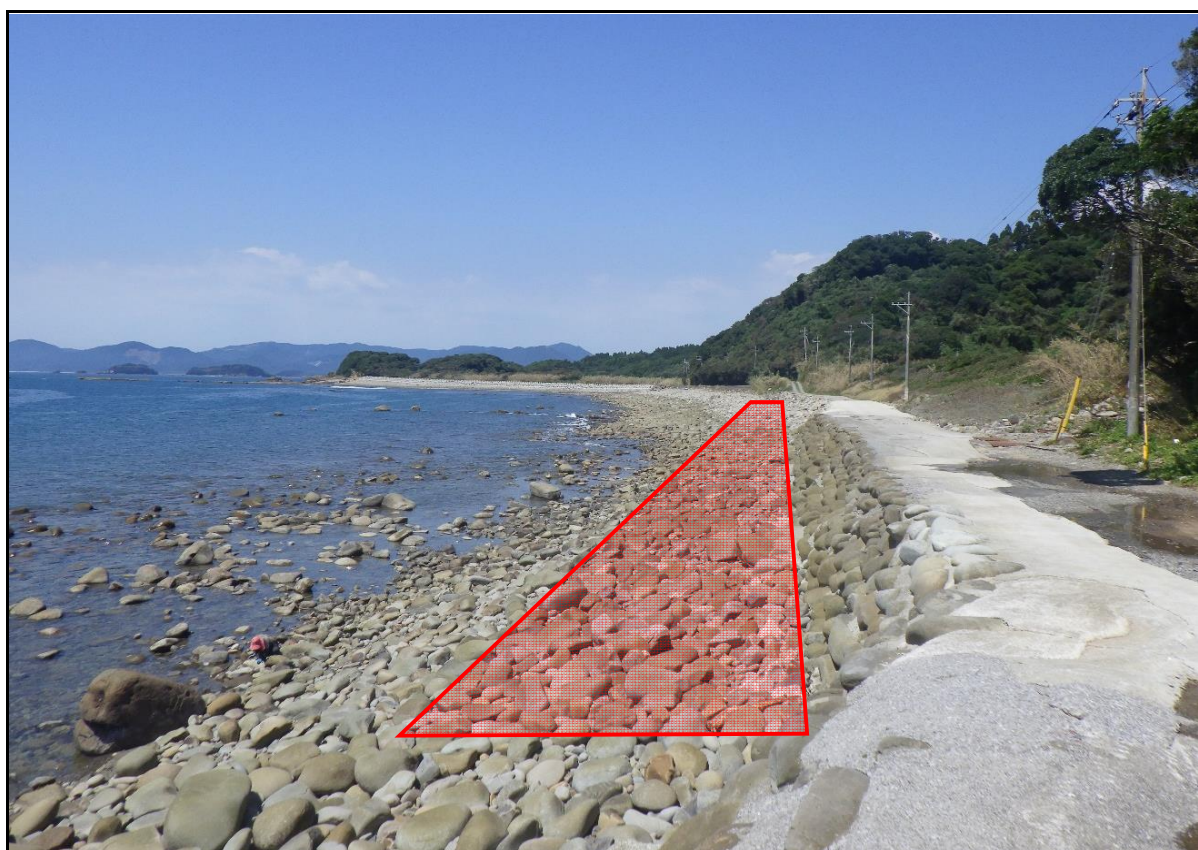
現地状況写真
