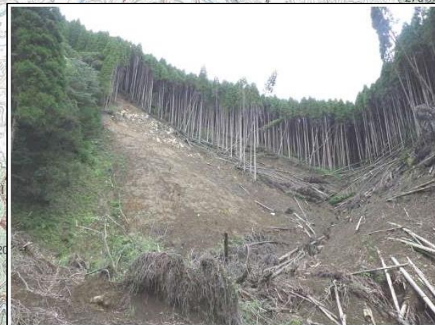
No.1 山腹工全景 画像 RIMG0001
