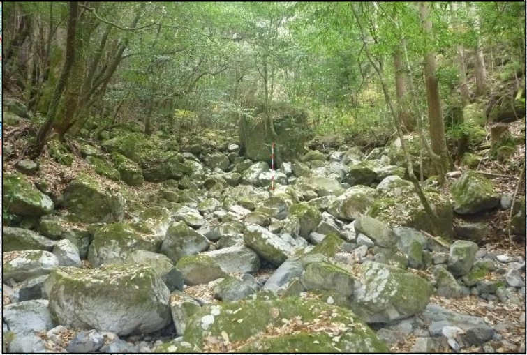
多武ノ木治山工事
