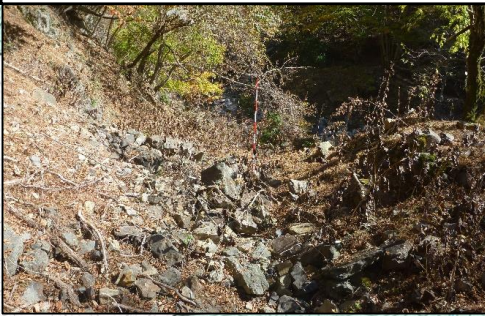
水無平 1 治山工事(谷止工)
