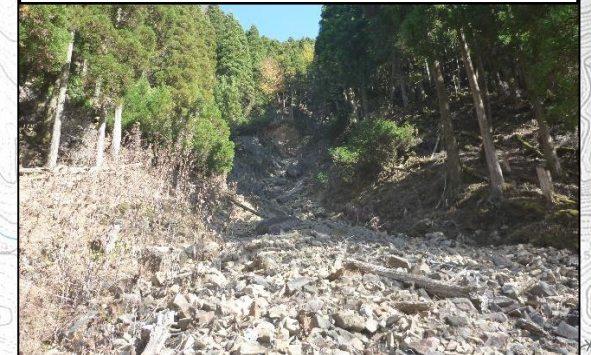
水無平 1 治山工事(山腹工)
