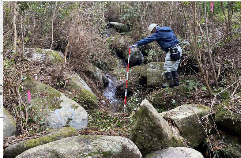
4: 作礼山治山工事
