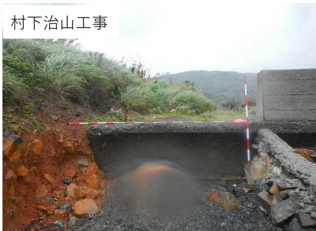
村下治山工事
