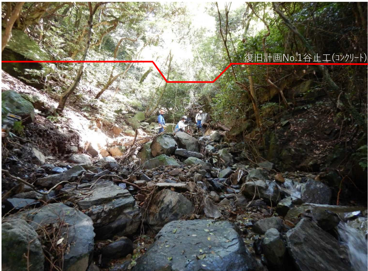
No.1谷止工施行箇所(下流から)
