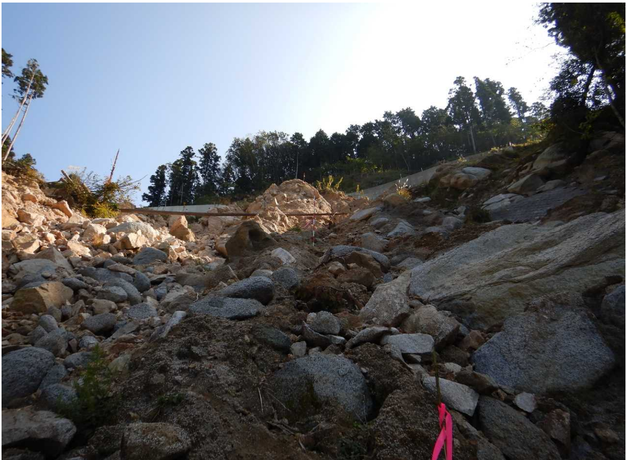
No.1山腹工施行箇所(下流から)
