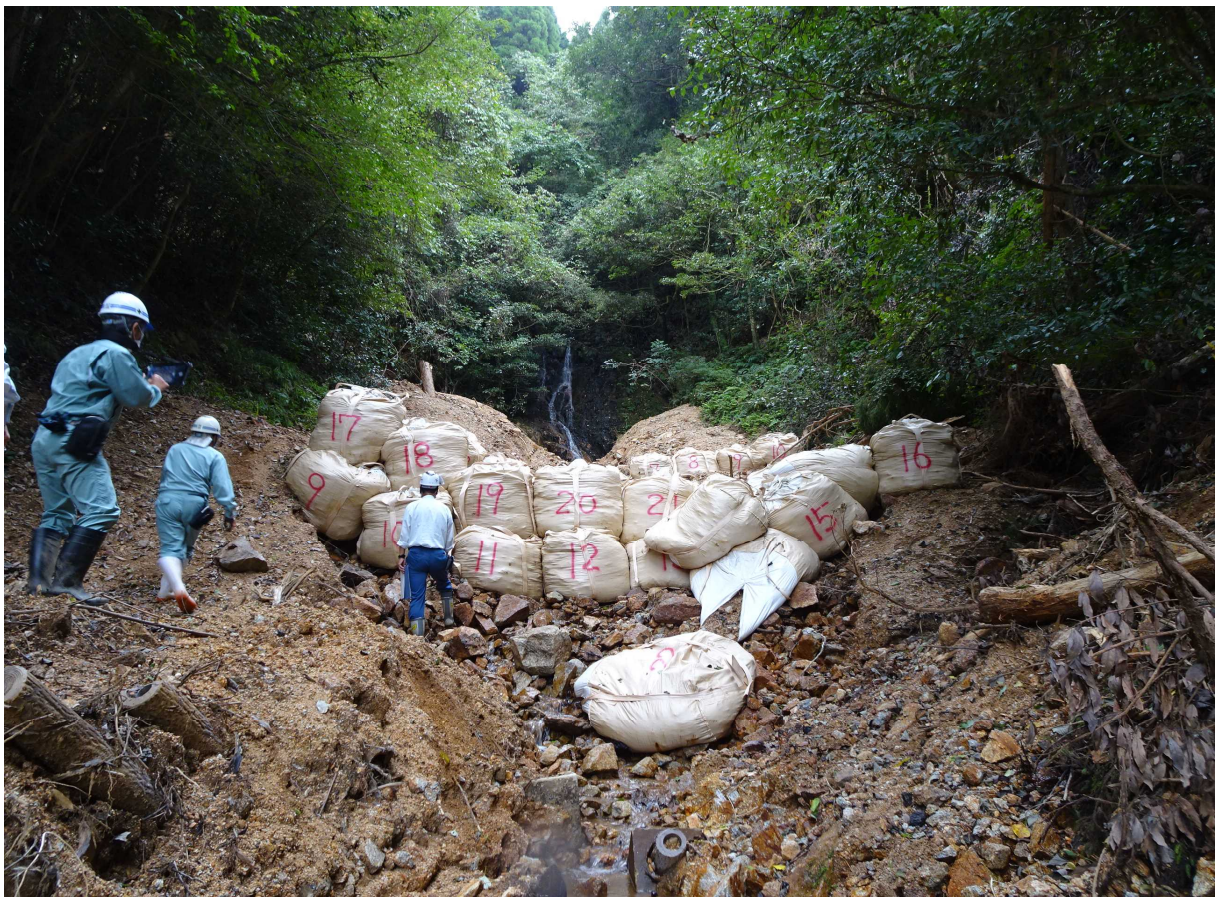
No.1谷止工施行箇所(下流から)
