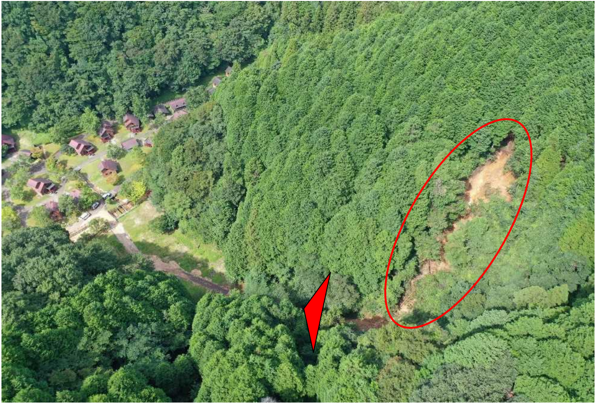
No.1谷止工及びNo.1山腹工の施行箇所(全景)
