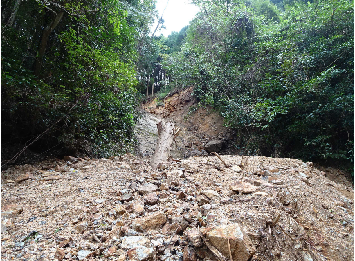
No.1山腹工施行箇所(下流から)
