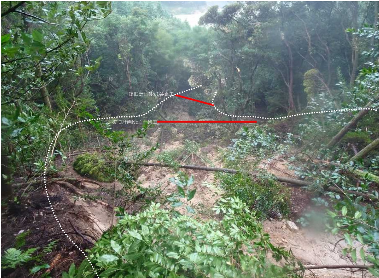
No.1山腹工施行箇所(上流から)
