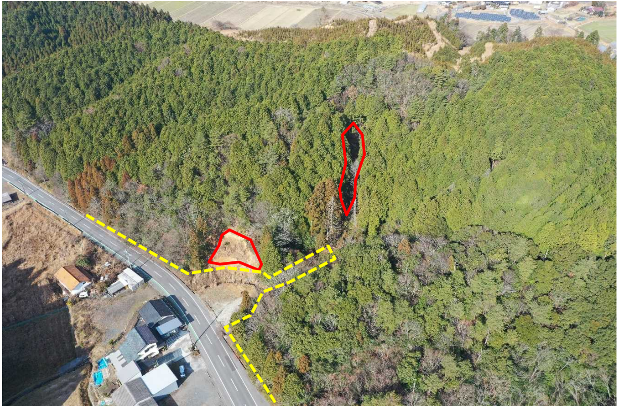
No.1山腹工及びNo.2山腹工の山腹施行箇所(全景)
