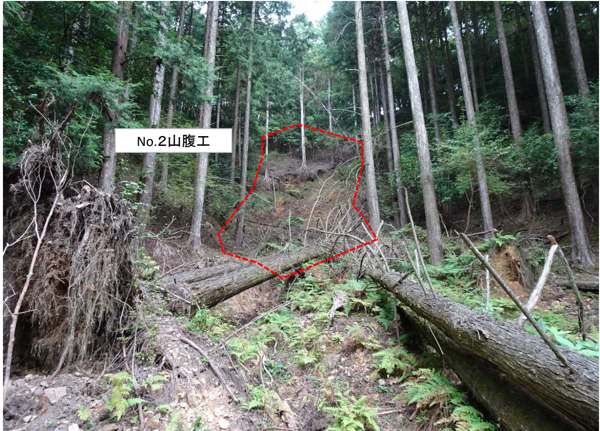
No.2山腹工施行箇所(下流から)
