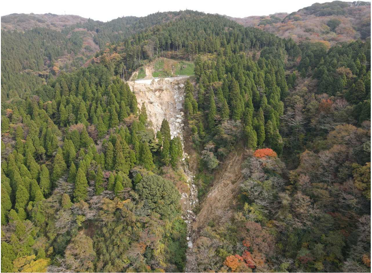
No.1山腹工及びNo.2山腹工の山腹施行箇所(全景)
