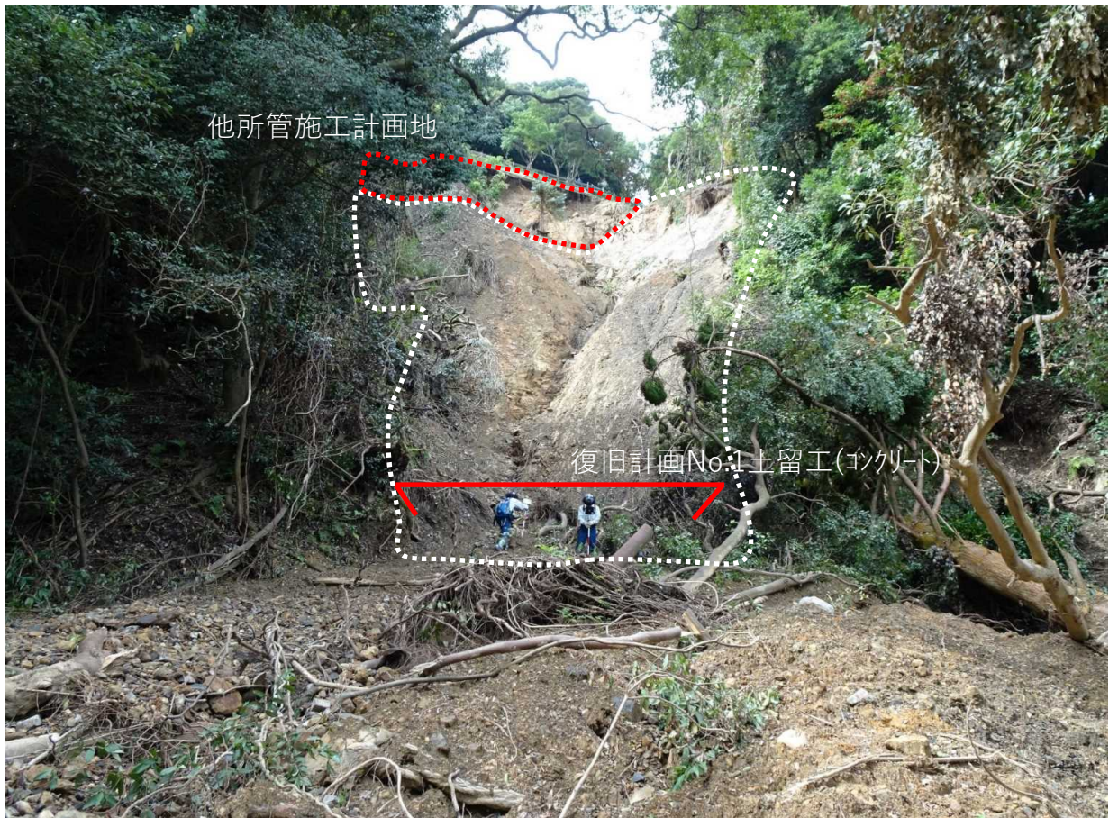
No.1山腹工施行箇所(下流から)
