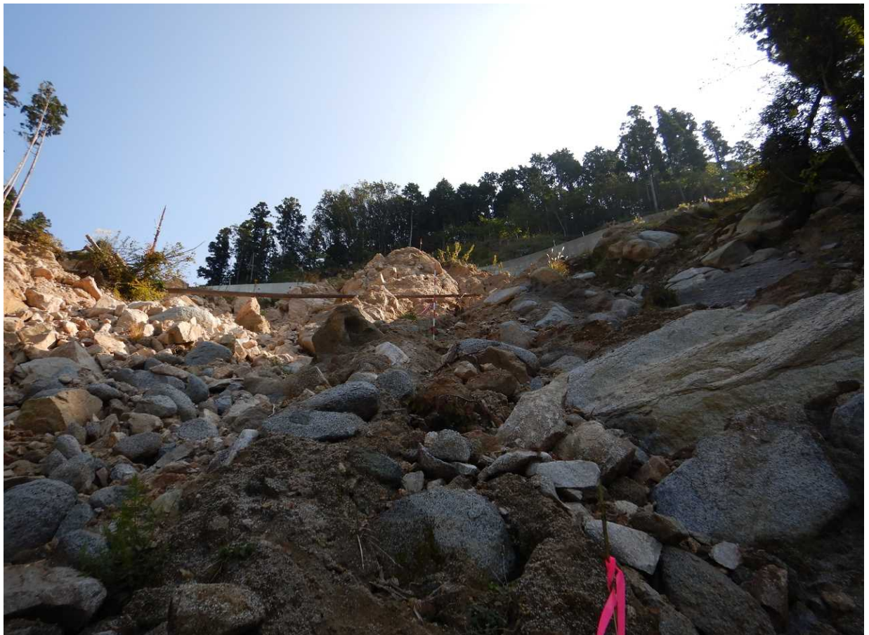
No.1山腹工施行箇所(下流から)
