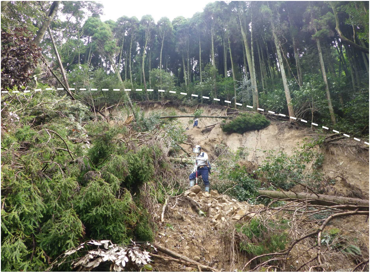
No.1山腹工施行箇所(下流から)
