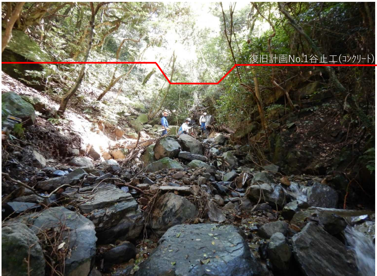
No.1谷止工施行箇所(下流から)
