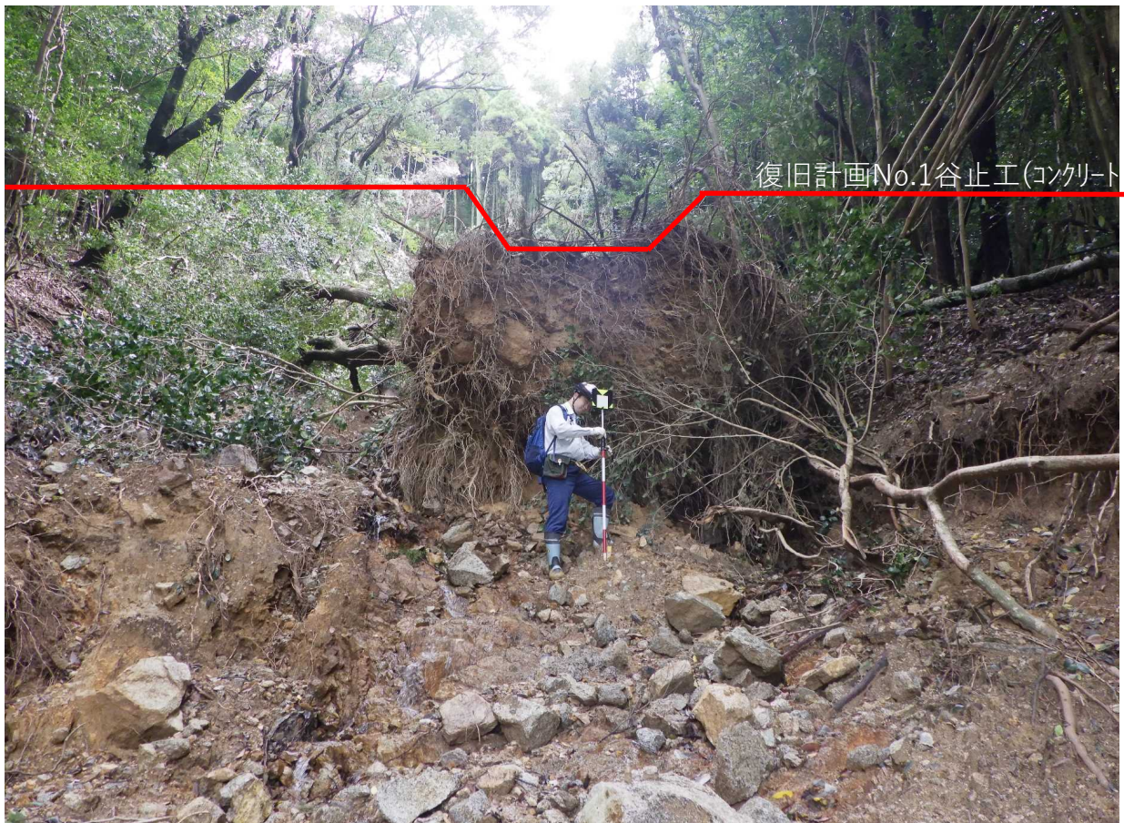
No.1谷止工施行箇所(下流から)
