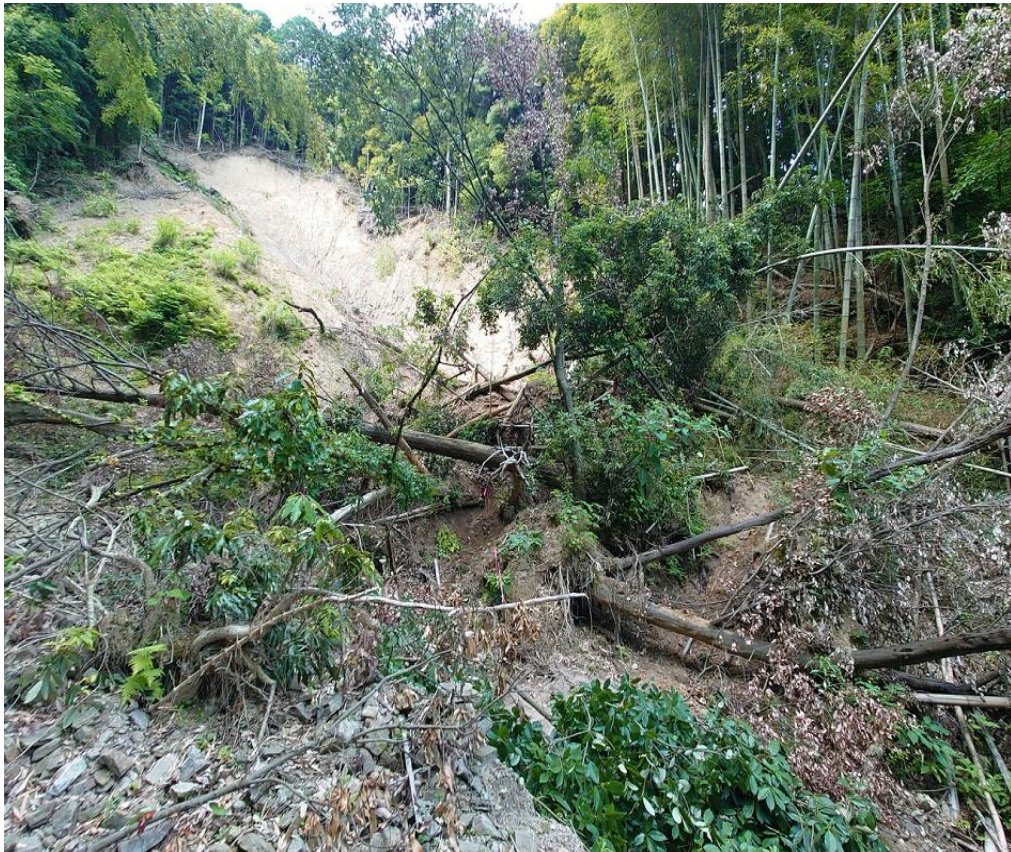
山腹工計画箇所全景
