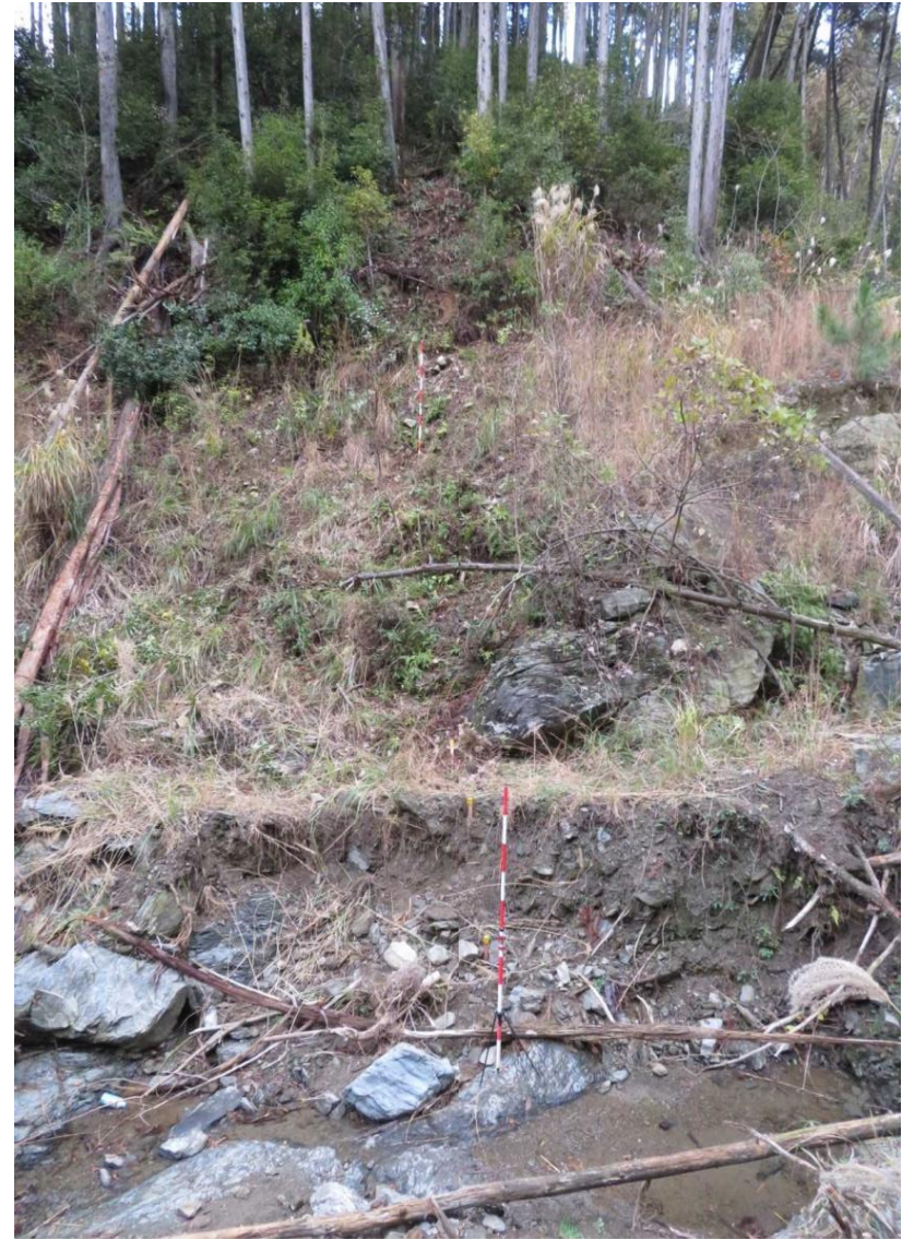
測点 No.23 右岸の状況
