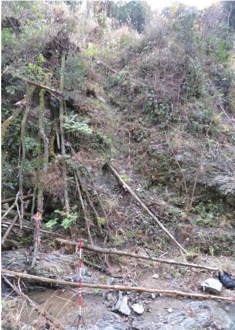
測点 No.23 左岸の状況
