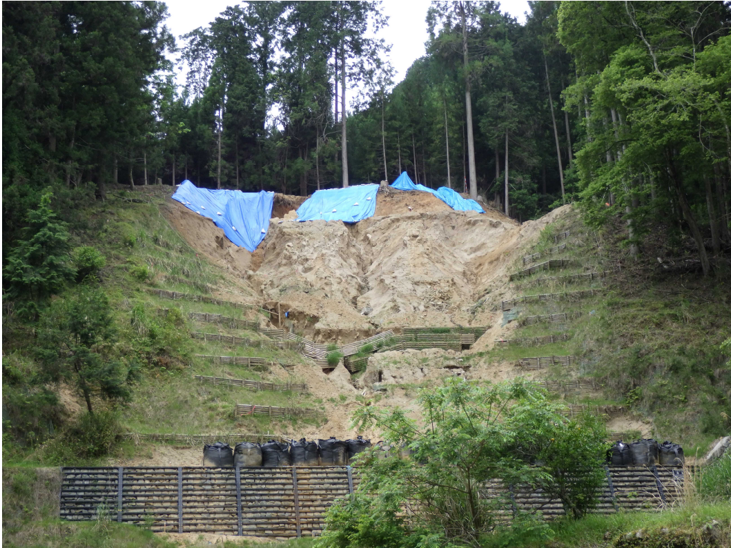
No.1 山腹工全景
