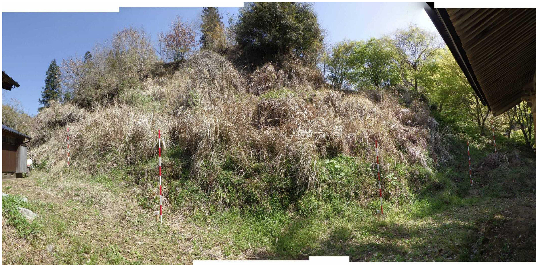
山腹の状況 (測点No.Y2~Y8)
