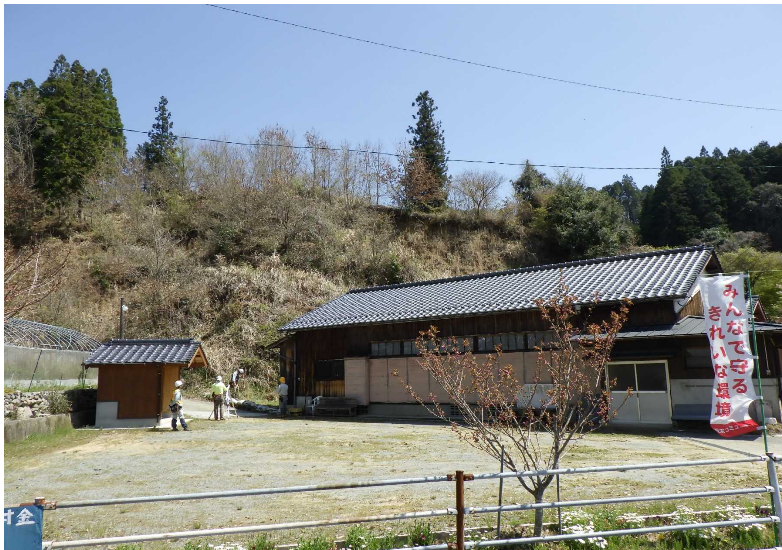
No.1 山腹工全景
