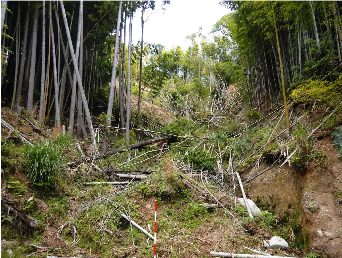
No.2 山腹工全景
